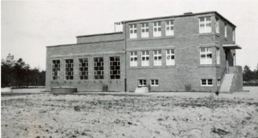
Wasserwerk am Diebesweg, um 1930. Seit Ende des 1920er Jahre kommt das Trinkwasser für Paderborn aus Tiefbrunnen am Rande der Senne. Foto: Stadt- und Kreisarchiv Paderborn S - M4, Bildnr. 19681-2 / Heinrich Gerke
